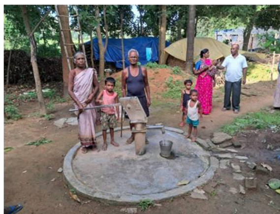
In 2025 hebben we diverse waterputten aangelegd voor de irrigatie van landbouwgewassen en voor schoon drinkwater in de dorpen en op scholen.
